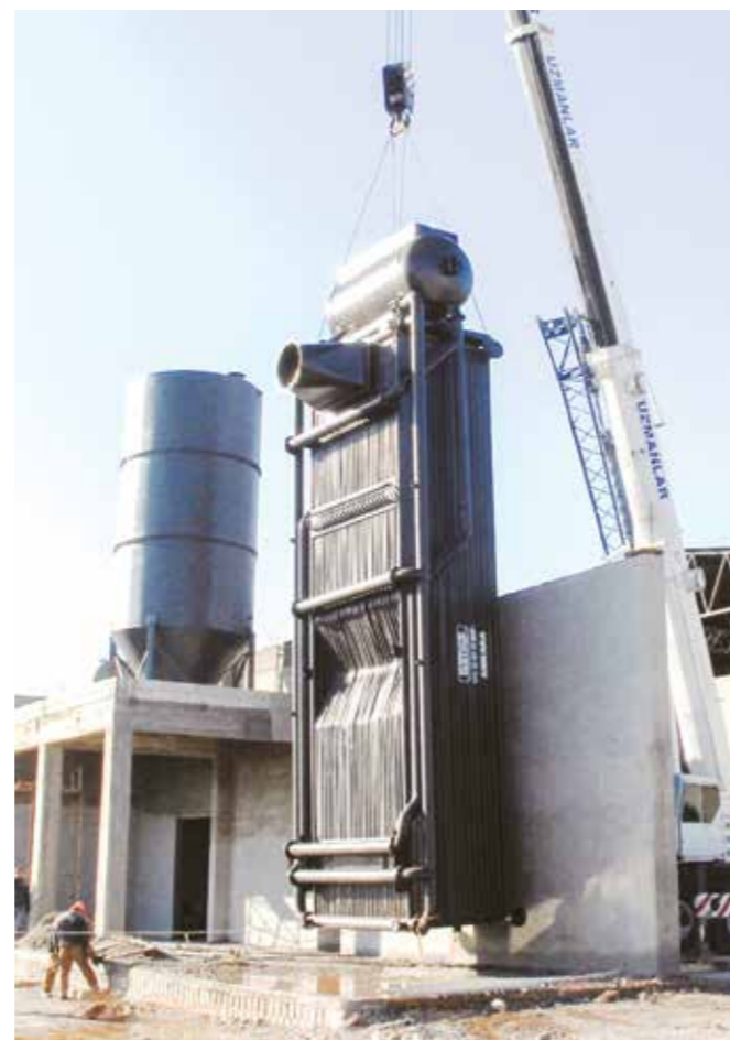
Топливо: уголь Производительность: 10 т. пара/ч Давление- 10 бар
